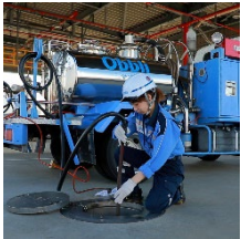
給油設備の点検業務
