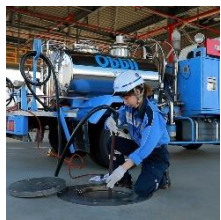
給油設備の 点検業務
